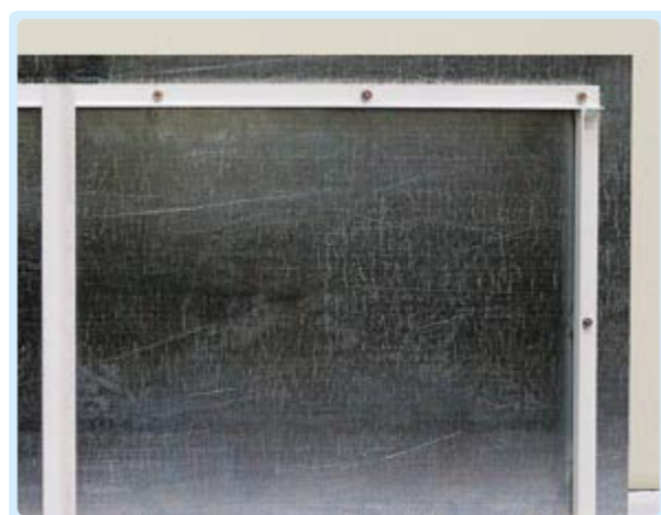
Для крепления табличек линейной части к ограждениям и для усиления прочности с обратной стороны предусмотрен металлокаркас.
